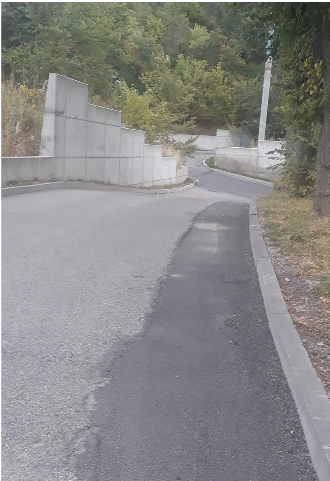
Укладка асфальта по ул. Керей-Жанибек Хандар (ул. Горная).
