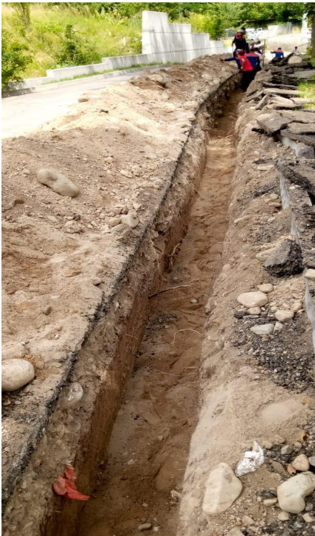
Разработка траншеи по ул. Керей-Жанибек Хандар (ул. Горная).
