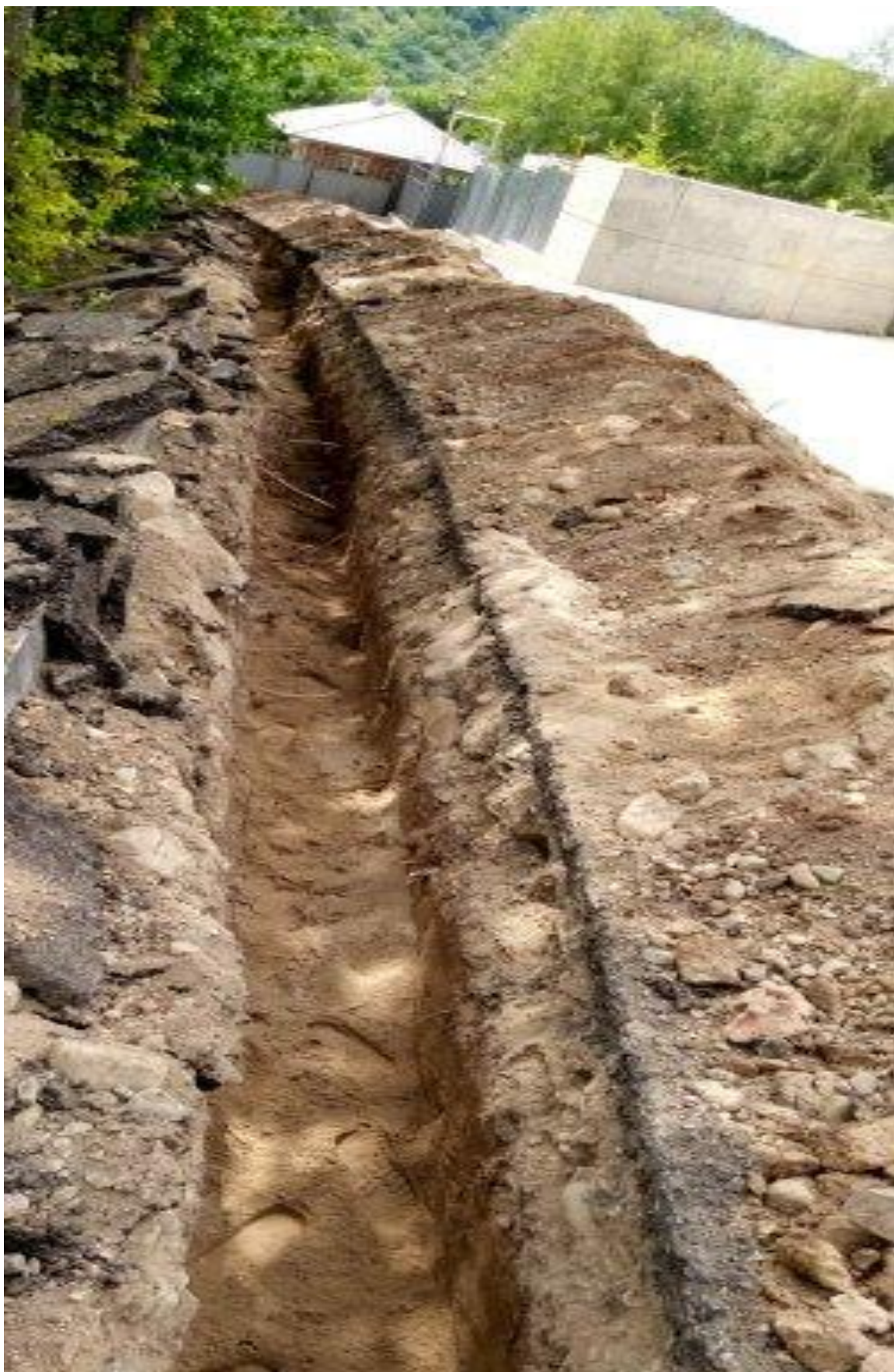
Разработка траншеи по ул. Керей-Жанибек Хандар (ул. Горная).
