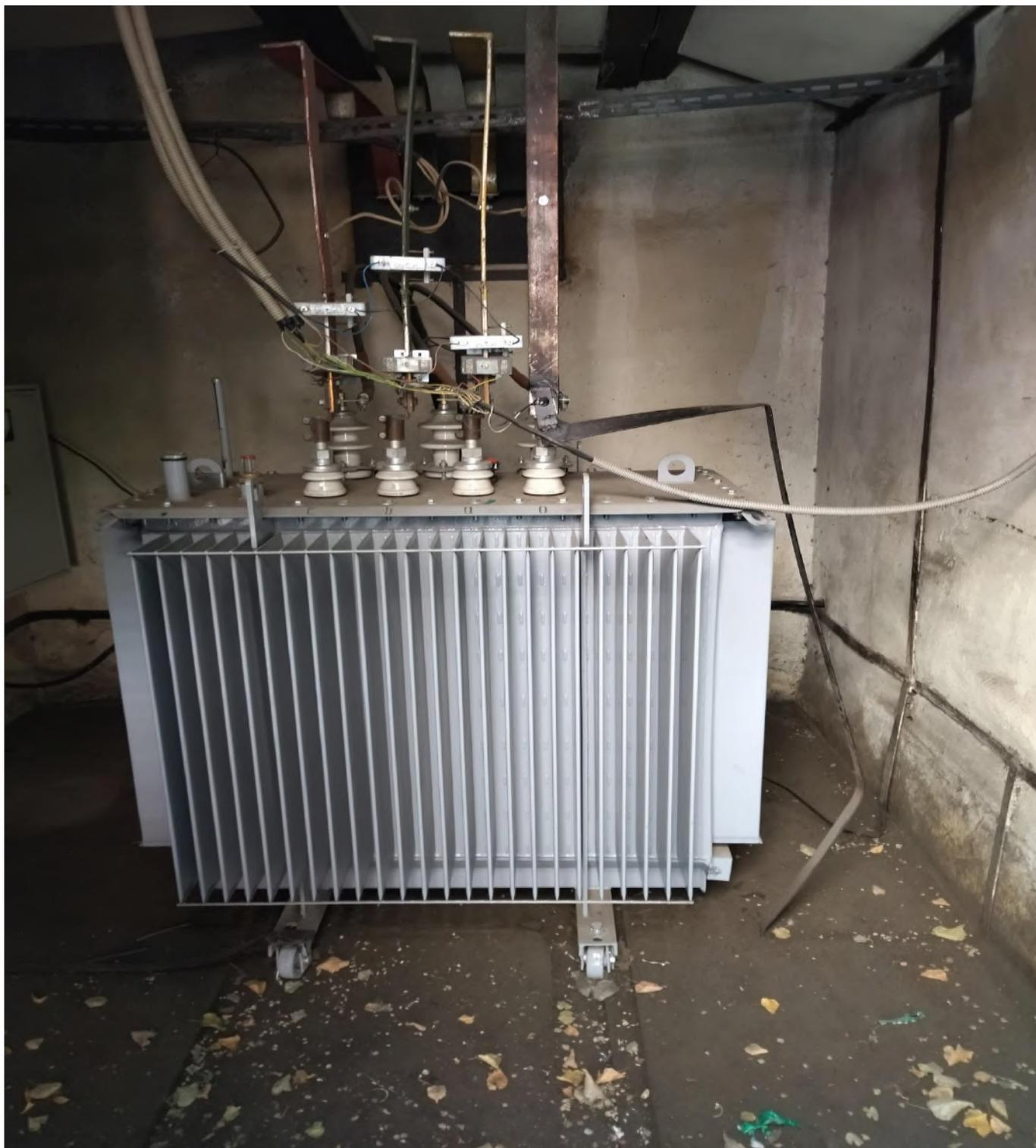
**Монтаж силового трансформатора 10/0,4 кВ, реконструкция оборудования в ТП РЭС-6 по проекту «Отрар».**
