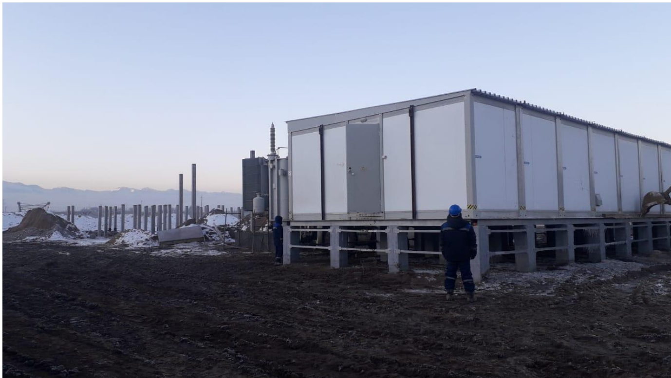
Монтаж блочно-модульного здания ЗРУ-10 кВ совмещенное с ОПУ ПС «Кокозек»
