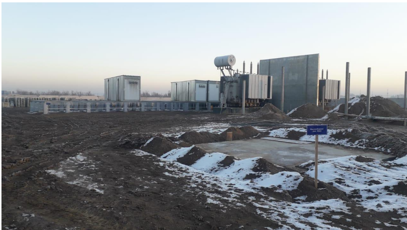
Монтаж силовых трансформаторов ТРМН- 63000 /110 –У1 на ПС «Кокозек»
