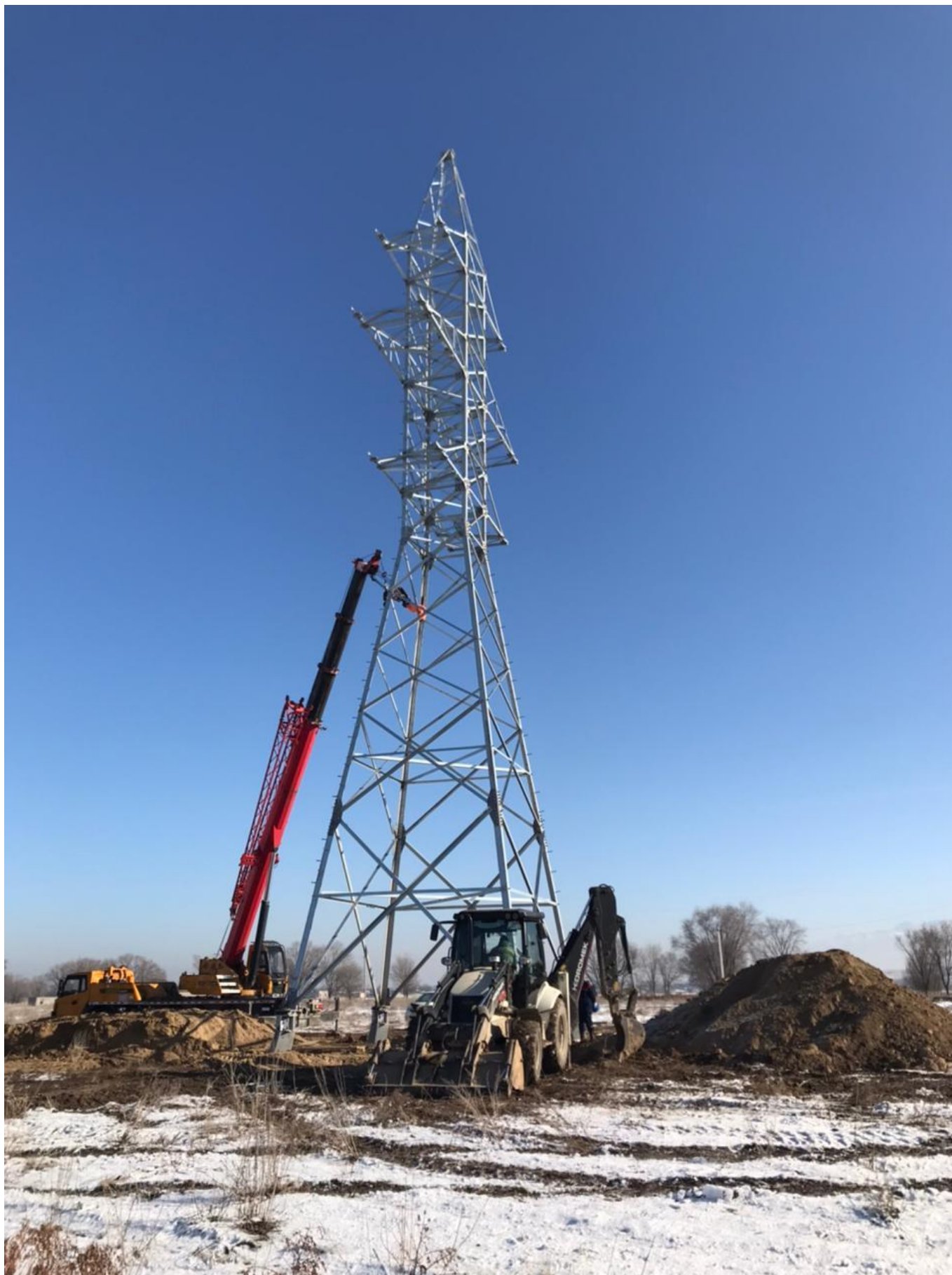
Монтаж анкерно-угловой опоры ВЛ-110 кВ ПС «Каскелен» ПС «Кокозек»
